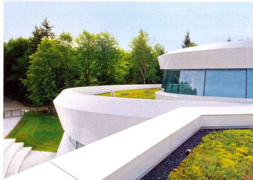
Detail Attika als Dachrandabschluss o.M.
