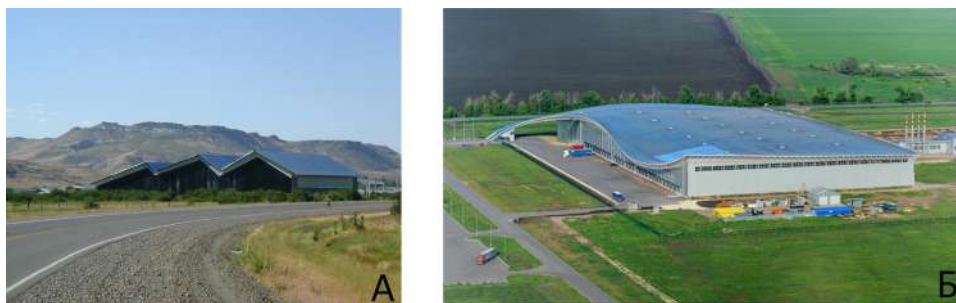
Рис. 1. Первый тип приемов – решение формы крыши большого производственного здания в соответствии с природным окружением: А – предприятие по производству полимерных труб в Аргентине; Б – мебельное предприятие «Ангстрем» в Воронежской области
