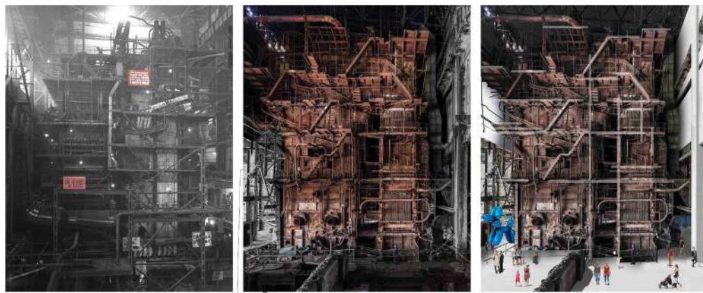
Рис. 2. Консервация элементов технологического оборудования
