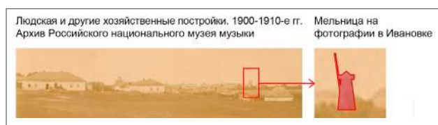
Рис. 2. Людская и другие хозяйственные постройки. Деревня Ивановка (1900–1910-е годы). Источник: Госкаталог РФ. – URL: https://goskatalog.ru/portal/#/collections?id=29480573
