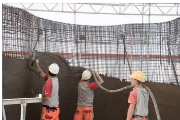
Рис. 2. Заполнение сетки бетоном методом торкретирования и последующее выравнивание
