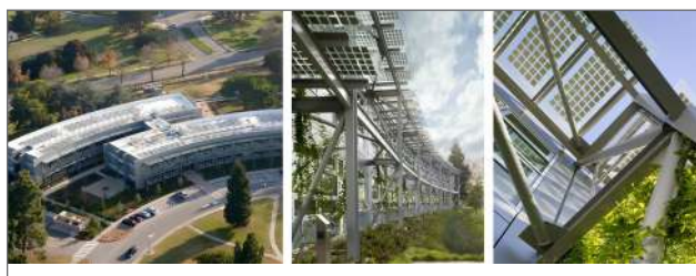
Рис. 2. Здание NASA Sustainability Base. Общий вид, элемент фасада
