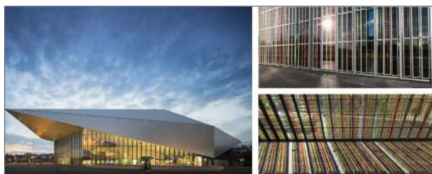
Рис. 1. Конференц-центр SwissTech. Общий вид, элемент фасада
